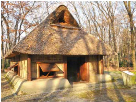
飛山城跡公園内に復元された古代竪穴建物
